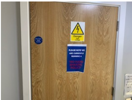
Fire Door signage
